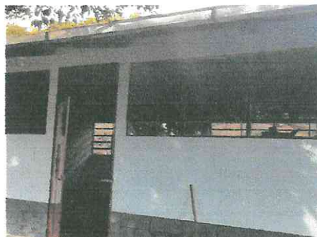
Mantenimiento de ventanales
