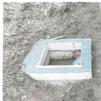
Reconstrucción de caja de drenaje para agua de pila y lavamanos
