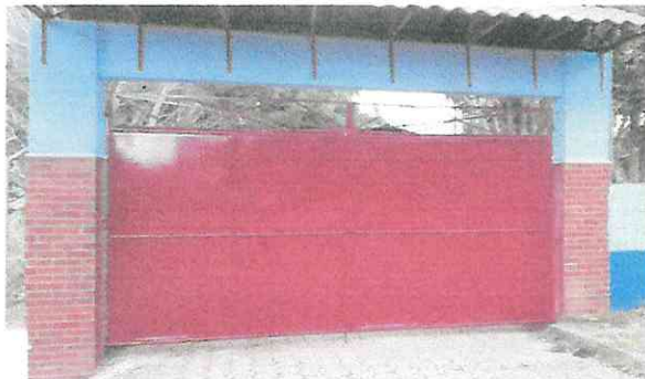
Mantenimiento de y colocación de lámina en portón
