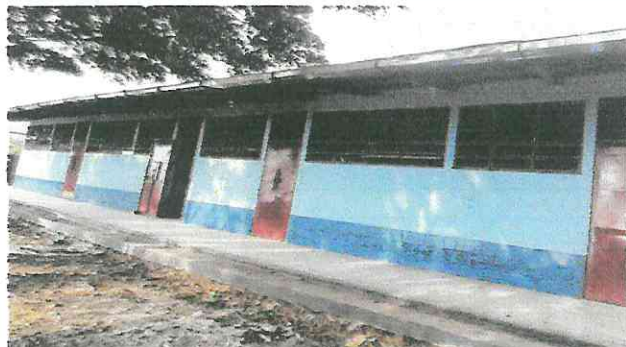
mantenimiento de puertas
