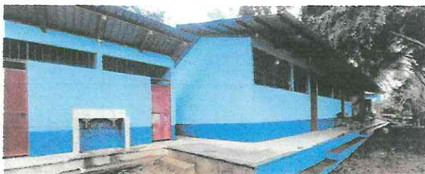
Limpieza de pintura en mal estado y colocación de nueva
